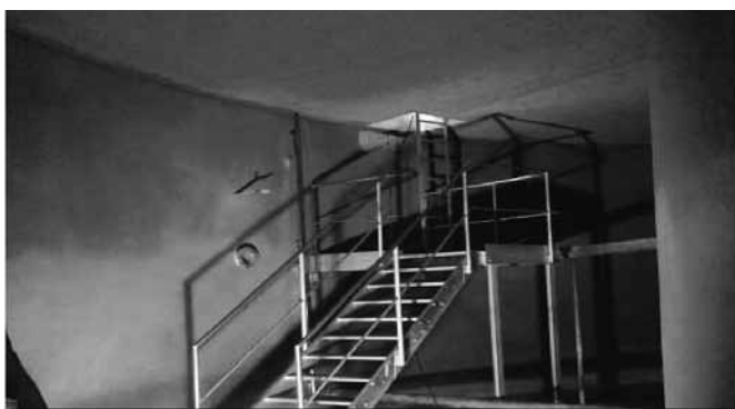
Blick in die Wasserkammer – neue Treppenanlage nach Fertigstellung Foto: privat
