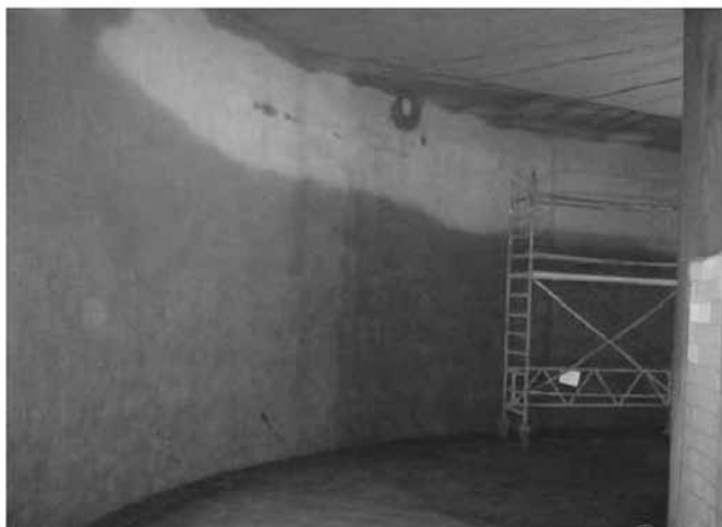
Blick in die Wasserkammer – nach dem Sandstrahlen Foto: privat
