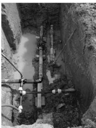
Anbindung neue PEHD-Leitung auf alte Grauguss-Leitung Foto: privat
