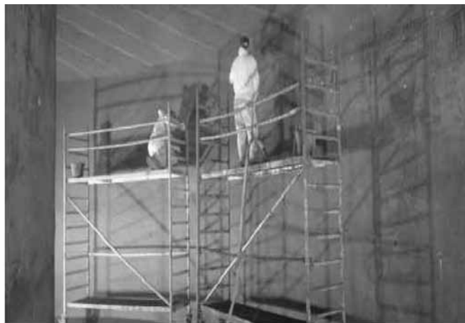
Blick in die Wasserkammer – Beschichtungsarbeiten Foto: privat
